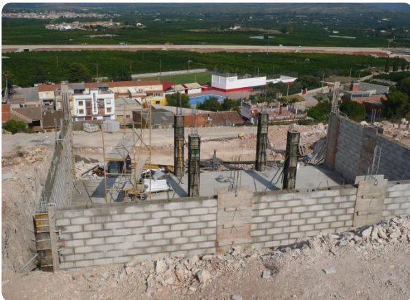
Ejemplo de construcción bajo de chalet con bloques "H" de 30
