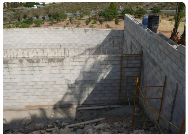
Ejemplo de construcción bajo de chalet con bloques "H" de 30
